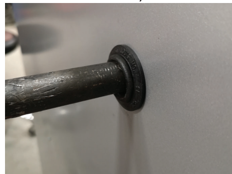
FIGURE 27 - RACCORDEMENTS DE LA CONDUITE DE GAZ DE LA FOURNAISE (NOTEZ L'ANNEAU EN CAOUTCHOUC)
