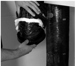
Insérer le conduit en vinyle par-dessus les quatre agrafes de fixation et serrer avec un collet de serrage (30 po).
